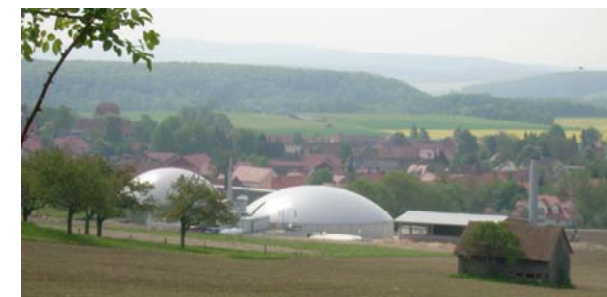
Site de bioénergie à Jühnde
