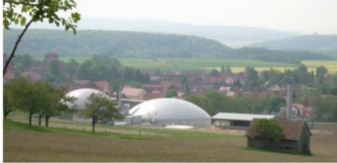
Die bei der Verbrennung des Biogases in einem Blockheizkraftwerk (BHKW) anfallende Wärme wird teilweise als Prozesswärme für den Gärprozess benötigt. Der überwiegende Teil jedoch steht für die Beheizung von Häusern zur Verfügung und kann dort Heizöl, Kohle oder Flüssiggas ersetzen. Durch die Nutzung der bei der Stromproduktion entstehenden Wärme kann bereits ca. 70 % des Wärmebedarfs der Jühnder Haushalte gedeckt werden.
